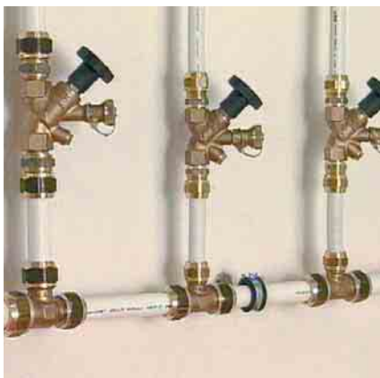
Монтаж арматуры с резьбовым соединением
