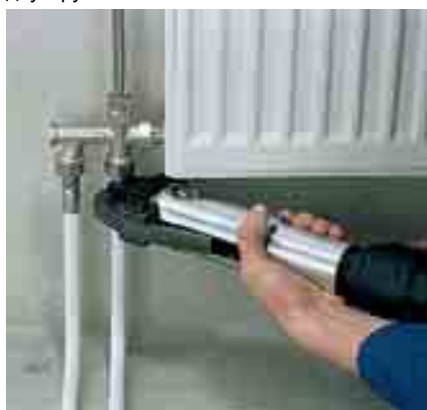
Напольное подсоединение с помощью присоединительных насадок для 1 - и 2-трубных систем
