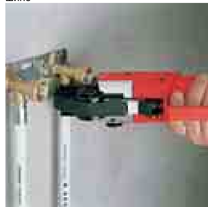
Прессовое соединение на монтажной шине
