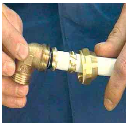
Труба „Coripe“ присоединяется к угольнику 90° „Cofit S“
